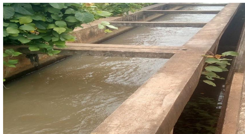
Canal principal d'irrigation réhabilité par le projet
