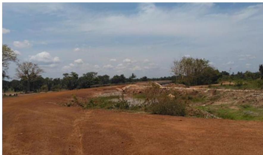
Une piste et une digue réalisées par le projet
